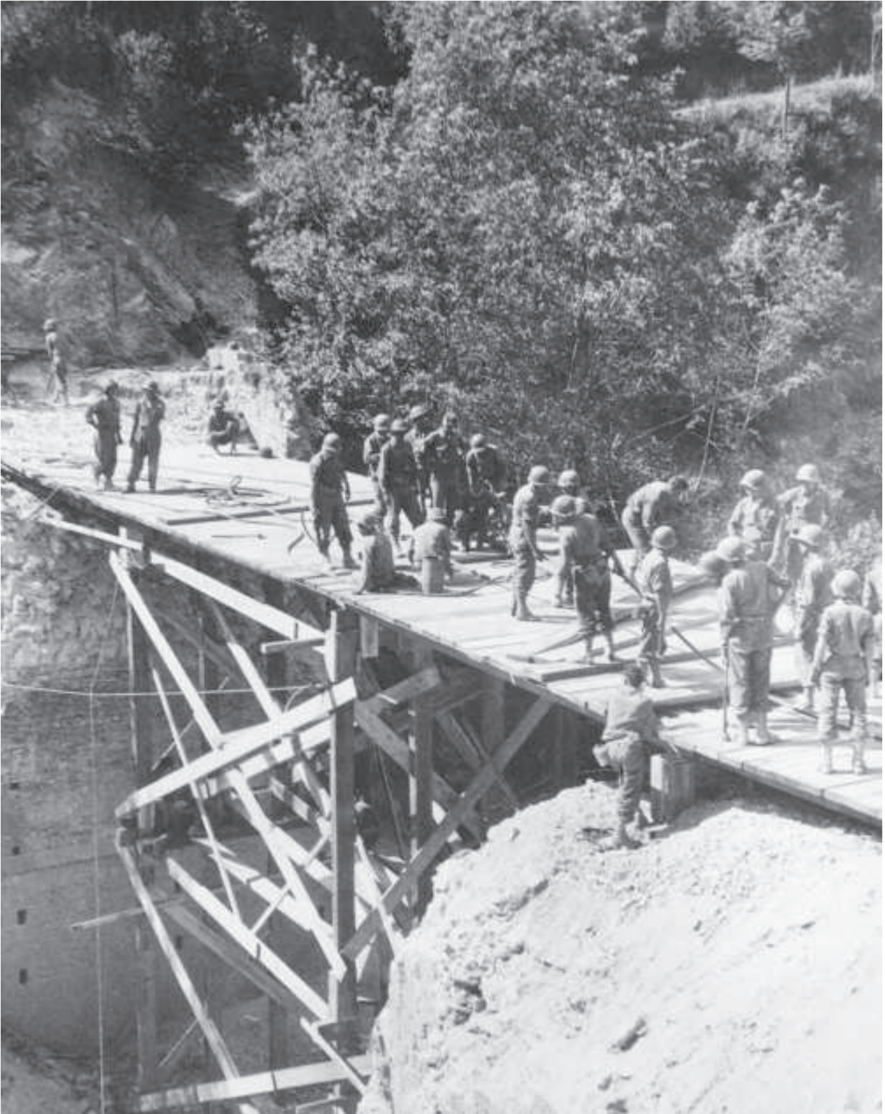
Uno dei tanti ponti distrutti dai tedeschi in ritirata in fase di ricostruzione da parte dei genieri americani, in prossimità di Acerno, sul fiume Tramasciuni (2 a metà sett. '43)
