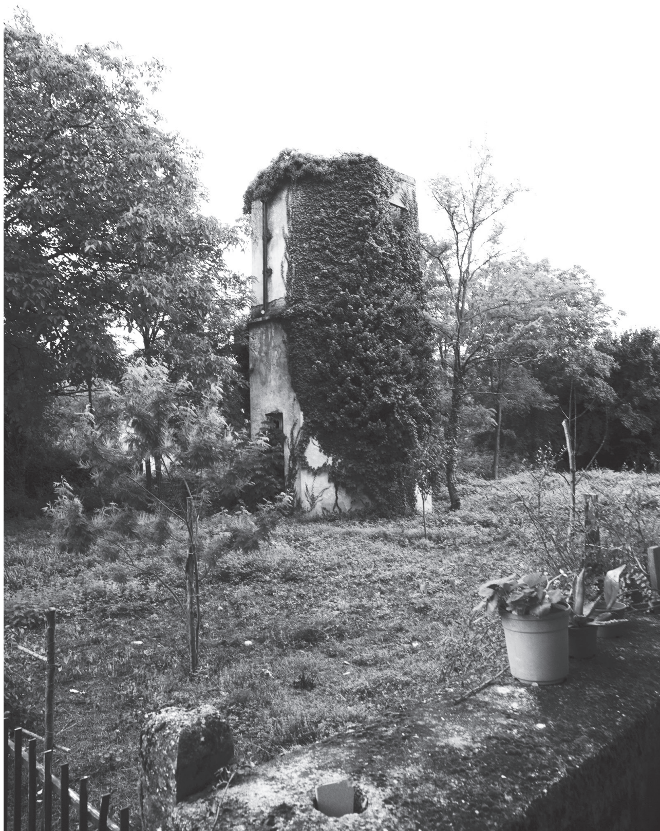
Il “silos” per il rifornimento dell’acqua al tempo delle locomotive a carbone
